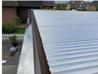
Aluminiumtrapezbleche oder Stahltrapezbleche in anthrazit & für PV- Anlagen geeignet . Inkl. Antikondesvliesbeschichtung
