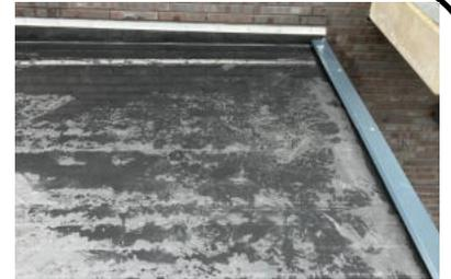
Holzdach und eine EDPM Dachabdichtungsabahn. Auch für Dachbegrünung & PV-Anlagen geeignet.
